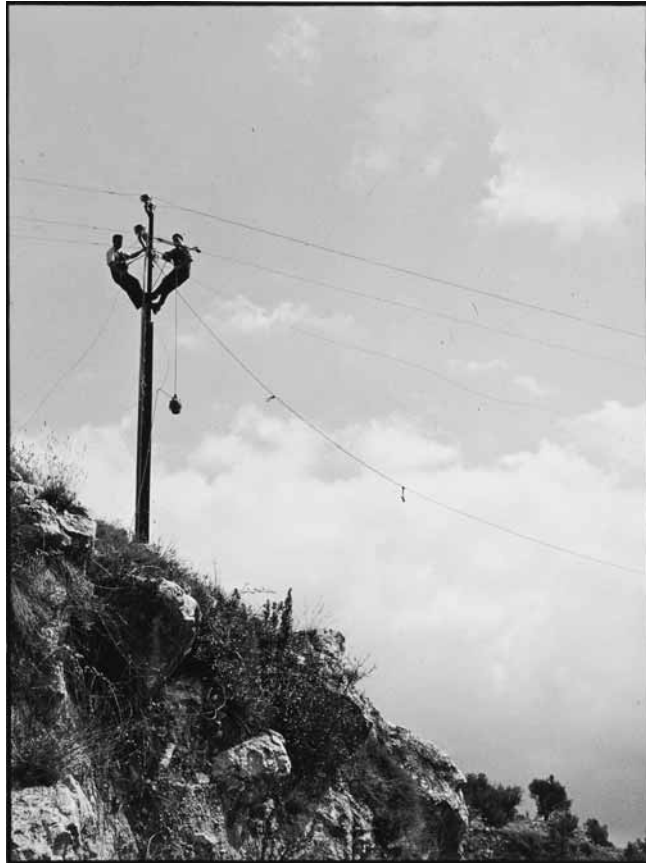
Reparació i càntir d'aigua Reparación y cántaro de agua Repairs and water pitcher Castellar del Vallès, 1960
